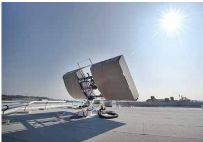
Abb.: Mit Fresnel-Linsen bestückte Suntracker auf dem Gebäudedach bündeln die Tageslichtstrahlung und koppeln sie in lichtleitende Fasern ein. (Quelle: ECHY)
