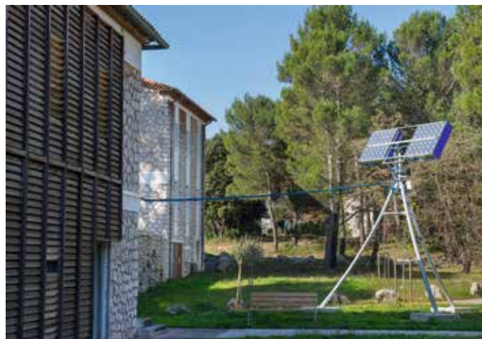
Abb.: Je nach Anwendung kann der Suntracker auch in Bodennähe platziert werden. (Quelle: ECHY)
